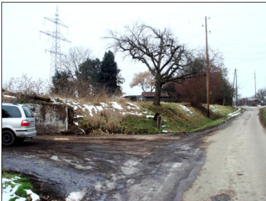
Situation Böschung und Fahrsilo vor Renaturierung Januar 2010
